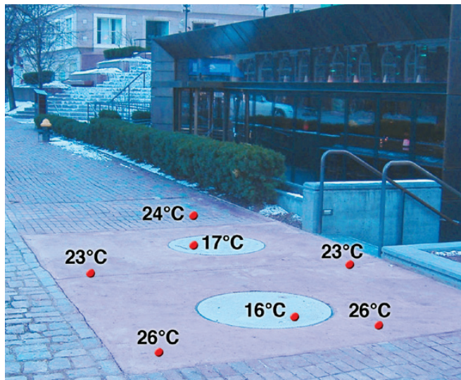
Las excelentes propiedades térmicas de los materiales compuestos mantienen frías al tacto las tapas a pesar de las altas temperaturas circundantes.
