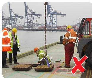
Schwere Schacht-abdeckungen benötigen oftmals aufwendiges Aushebewerkzeug
