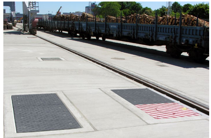
Las tapas Fibrelite se diseñaron y fabricaron a medida para encajar directamente en las aberturas existentes, minimizando el tiempo de instalación.
