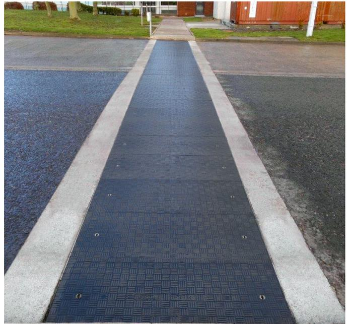
*I chiusini di accesso Fibrelite sono stati progettati per resistere a carichi pesanti e a rigide condizioni meteo*
