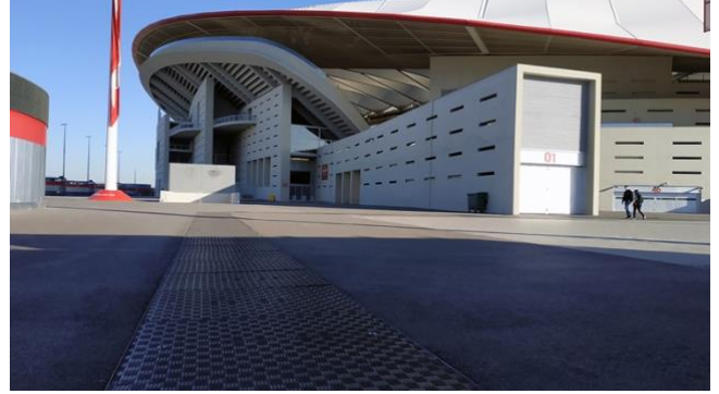
تركيب أغطية الخنادق من شركة فيبرلايت "Fibrelite" في استاد جديد في إسبانيا.
