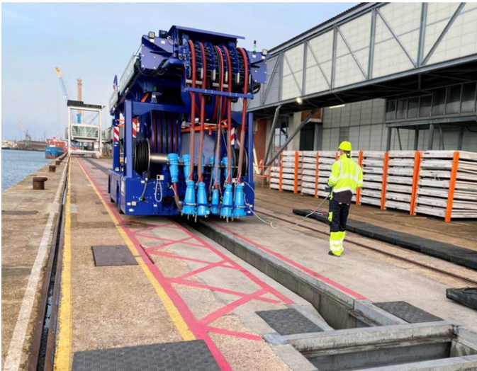
Suministro Eléctrico en Tierra (OPS) para terminal de cruceros en Reino Unido
