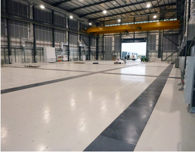
Fibrelite, bu üretim ve araştırma tesisi için ısmarlama bir kompozit kanal kaplama düzenlemesi sundu
