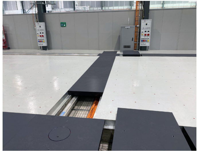
Fibrelite kapakları müşteri talebine uygun olarak yüzeyde desen olmayacak şekilde kalıplandı
