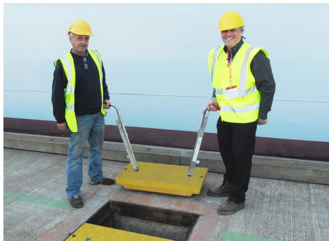
Las cubiertas de zanja ligeras F900 de Fibrelite pueden ser retiradas con seguridad y rápidamente por 2 personas (la imagen se usa como ilustración y muestra una instalación diferente)
