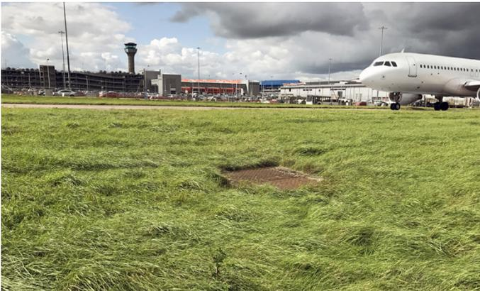
Las cubiertas Fibrelite permiten una sustitución ligera para retroinstalación en lugar de las pesadas cubiertas de zanjas de hierro fundido del aeropuerto regional del RU
