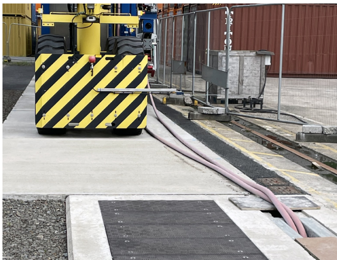
Plaques de tranchée Fibrelite F900 légères sur des fosses d'ancrage de câbles
