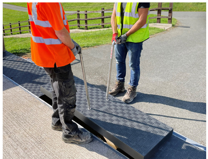
Accès facile aux services de tranchée à l'aide des poignées de levage ergonomiques Fibrelite FL7 (Image utilisée à des fins d'illustration et montrant une installation différente)
