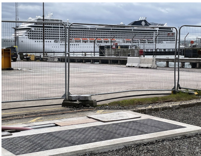
Tampas de acesso a valas Fibrelite personalizadas com armações em aço galvanizado a quente
