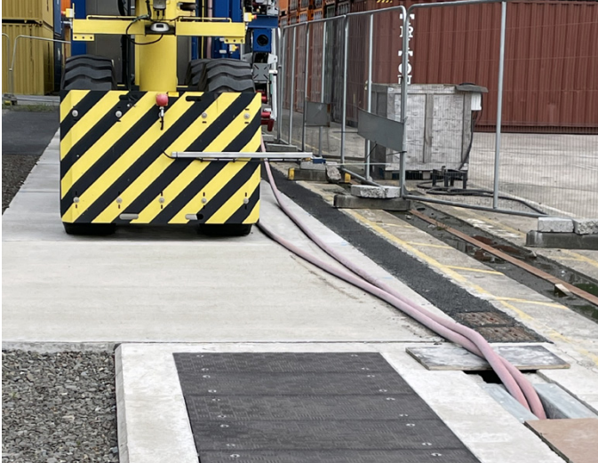
Coberturas de valas Fibrelite F900 leves sobre poços de ancoragem de cabos
