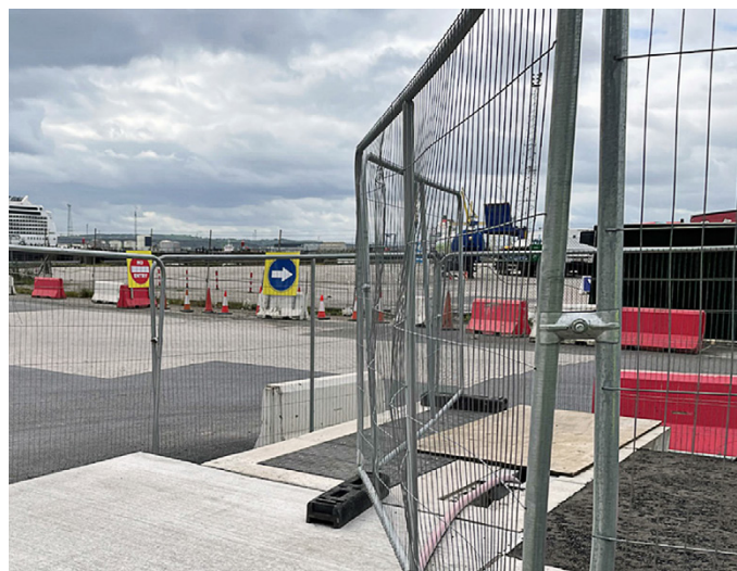
Foram necessárias coberturas com capacidade de carga F900 (90 toneladas)
