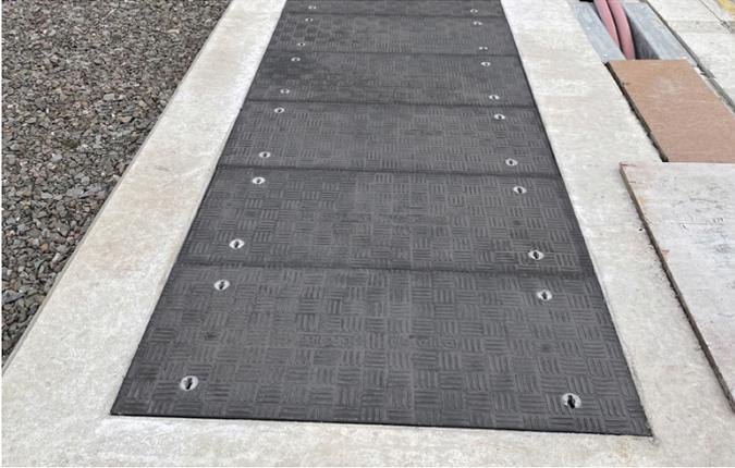
Las cubiertas de zanja se escalonaron en profundidad de 117 mm a 150 mm para lograr la capacidad de carga nominal requerida F900.
