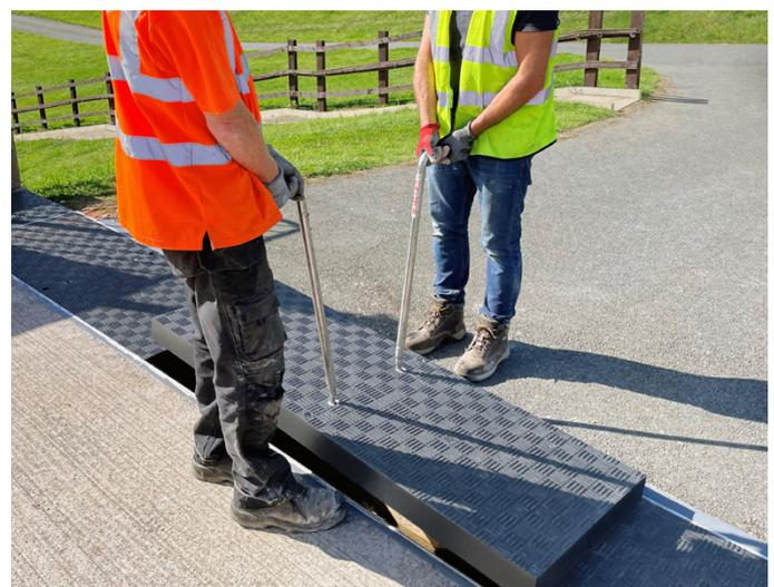
Fácil acceso a servicios en zanjas gracias a las asas de elevación FL7 de Fibrelite ergonómicamente diseñada (la imagen se usa como ilustración y muestra una instalación diferente)
