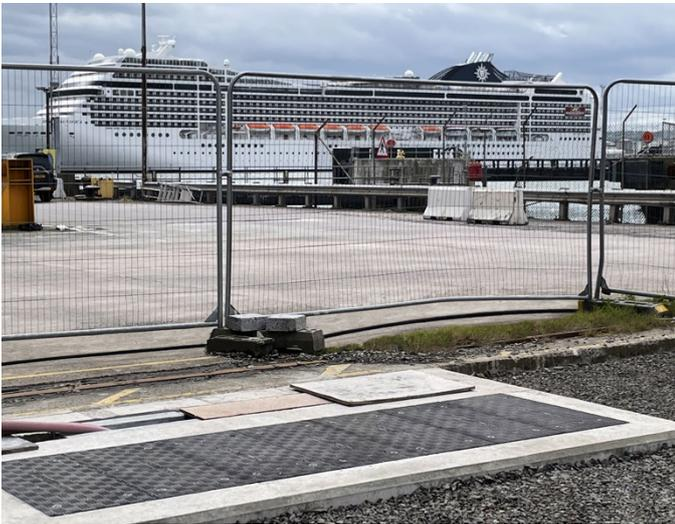
Cubiertas de acceso de zanja Fibrelite personalizadas con marcos de acero galvanizado por inmersión en caliente
