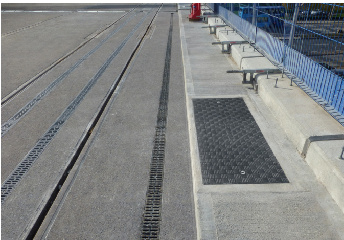
Tampas de caleiras sobre medida para equipamento de manutenção
