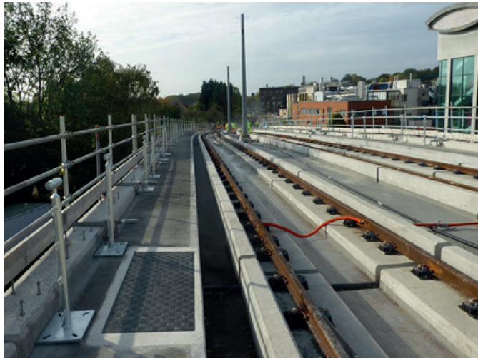
Pokrywa do kanałów Fibrelite w klasie obciążenia B125 (12,5 tony)
