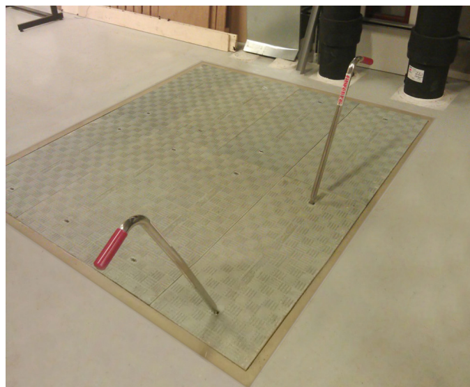
Rączka FL7 pozwala na łatwe i bezpieczne ściągnięcie pokryw
