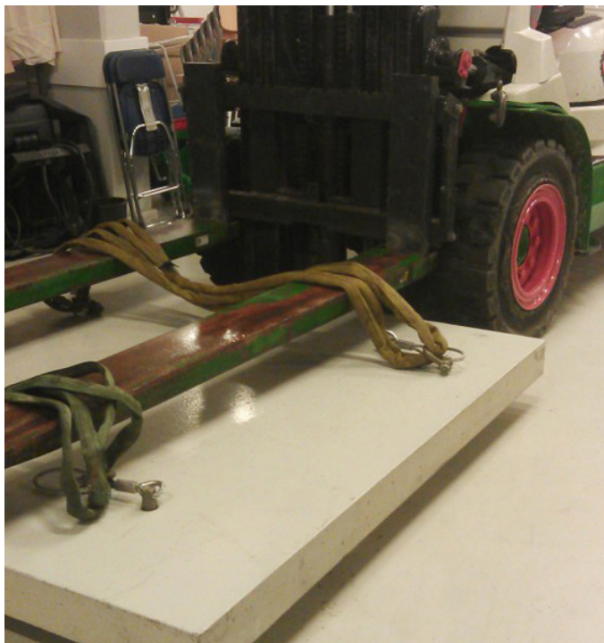
Dawna czasochłonna metoda usuwania ciężkiej płyty betonowej
