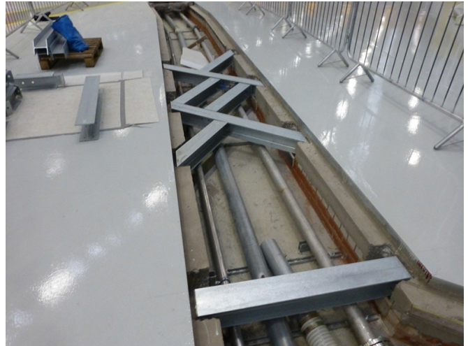
Faserverbundabdeckungen wurden den vorinstallierten Stahlträgern angepasst
