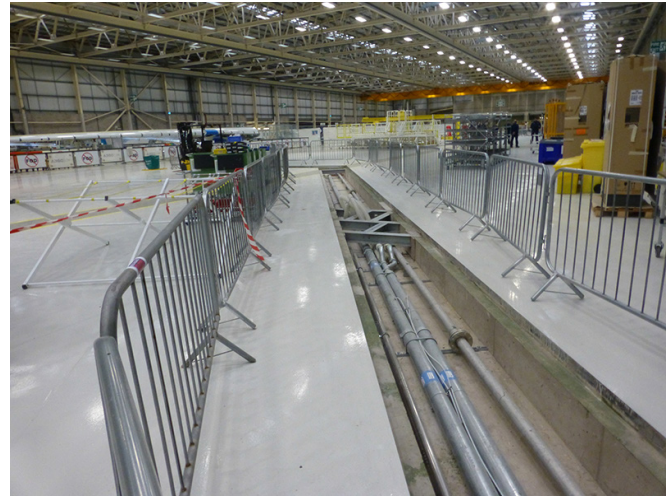
Technikkanal vor dem Einbau der Abdeckungen
