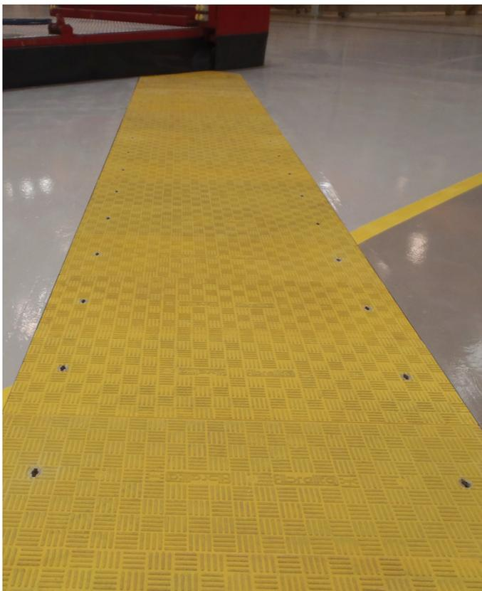
Желтые крышки для траншей со стандартной номинальной нагрузкой C250 (25 тонн) компании Fibrelite
