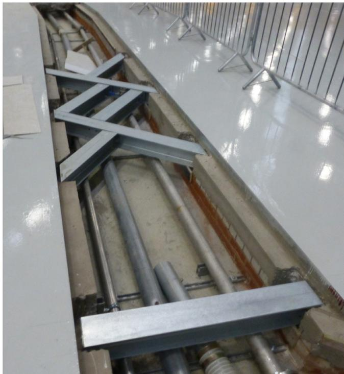
Крышки Fibrelite, которые необходимо изготовить для предварительно установленных стальных опор
