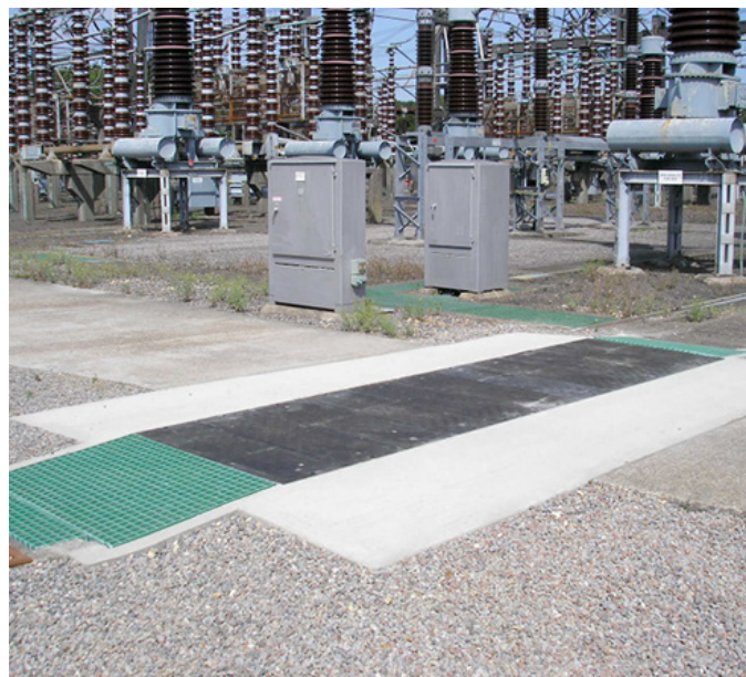
Fibrelite D400 בעל עמידות בעומס של טון מקטגוריית מכסי שוחה קלים
