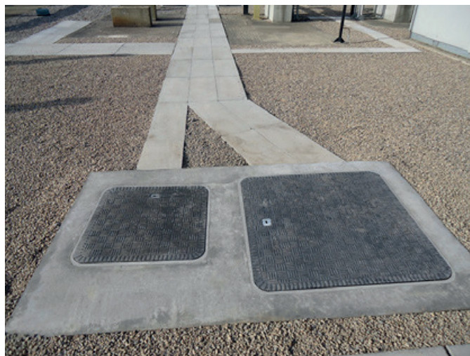
Zainstalowane szczelne pokrywy dostępne Fibrelite
