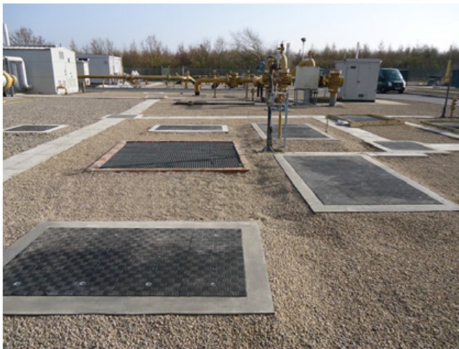
Skorodowane i zniszczone pokrywy żeliwne oraz betonowe zostały zastąpione lekkimi panelami pokryw do kanałów Fibrelite
