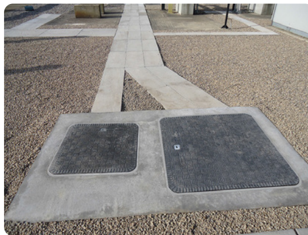
Zainstalowane szczelne pokrywy dostępne Fibrelite
