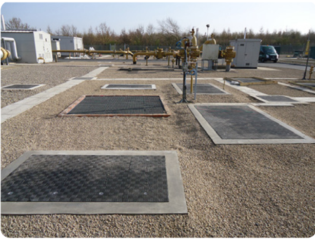
Skorodowane i zniszczone pokrywy żeliwne oraz betonowe zostały zastąpione lekkimi panelami pokryw do kanałów Fibrelite
