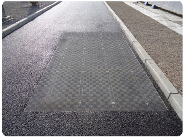
Pokrywy o klasie obciążenia D400 zainstalowane na drodze dojazdowej na obiekt
