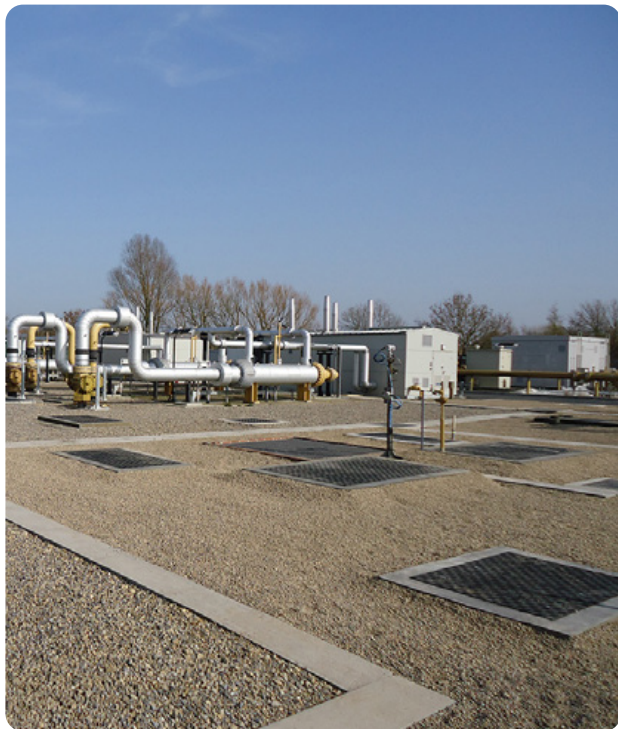
Lekkie pokrywy dostępne oraz do kanałów w klasie B125 (12,5 tony)
