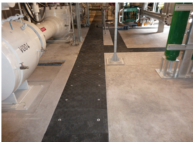
Powłoka antypoślizgowa jest nakładana na górę paneli
