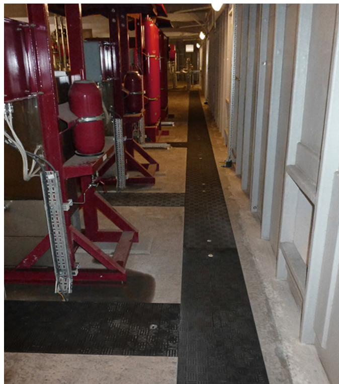
Zamontowano pokrywy o różnych długościach i kształtach
