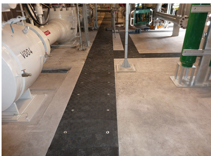
Powłoka antypoślizgowa jest nakładana na górę paneli
