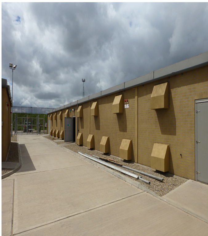
Stacja gazowa w Wielkiej Brytanii
