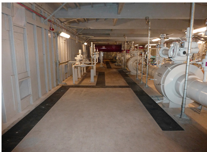
Specjalnie wycięte panele zostały zamontowane wokół zaworów i rur
