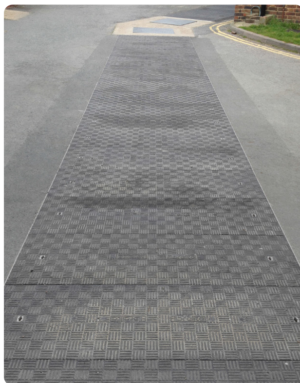
Le rendu final après l'installation des tampons Fibrelite
