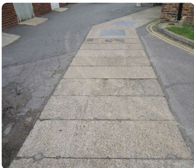
Les dalles en béton précédemment installées
