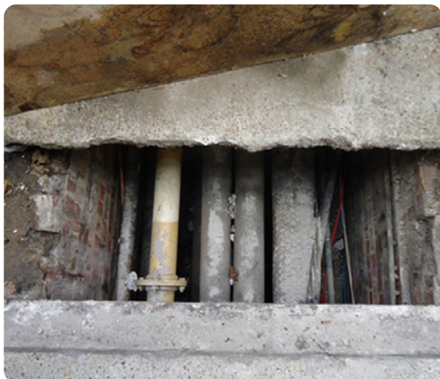
Le béton effrité et endommagé laissait apparaître les conduites de chauffage
