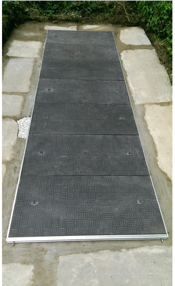
Paneles químicamente inertes y resistentes a la corrosión
