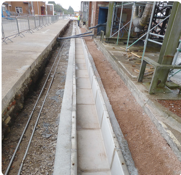
Plac budowy od zainstalowania lekkich paneli kompozytowych aż do wykończenia przez montaż 190 nowych pokryw Fibrelite
