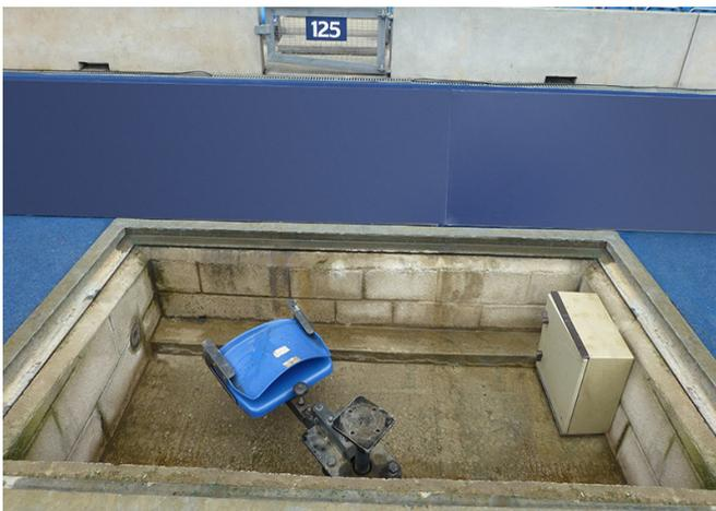
Existierende Kameragrube, vorbereitet für Fibrelite Abdeckungen
