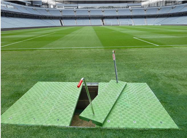
Große Spannweite: Fibrelite Verbund-Abdeckungen sind bis zu 1600 mm Länge lieferbar, bei einer Belastung bis D400 (40 Tonnen)
