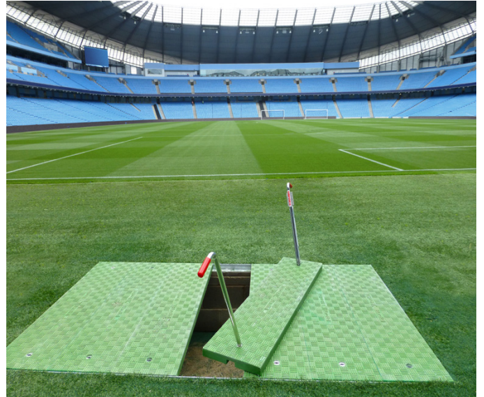
כיסוי נרחב: מכסי שוחה של Fibrelite מגיעים עד לאורך של 1600 מ"מ בדירוג עומס של D400 (04 טונות)
