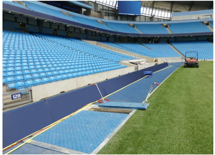
Las tapas de zanja de Fibrelite y la ayuda de elevación diseñada ergonómicamente permiten una retirada segura y fácil
