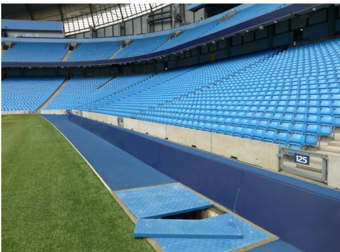
Las tapas de zanja Fibrelite tienen una superficie antideslizante
