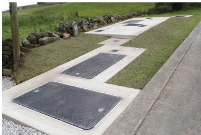
Fibrelite kompozytowe pokrywy włazów
