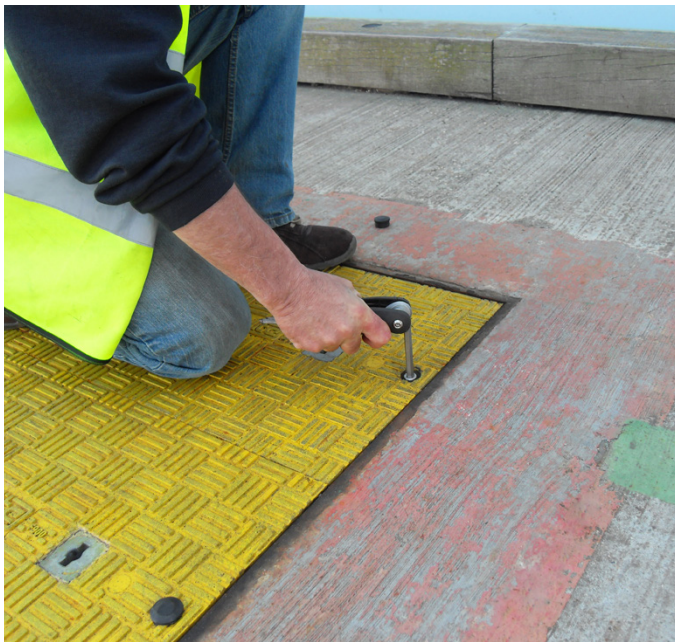
Operatør som fjerner Fibrelite-sikringsystemet
