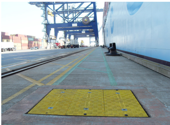
Lette grøftedekslar fra Fibrelite med 90 tonnns bæreevne på plass på kaikanten
