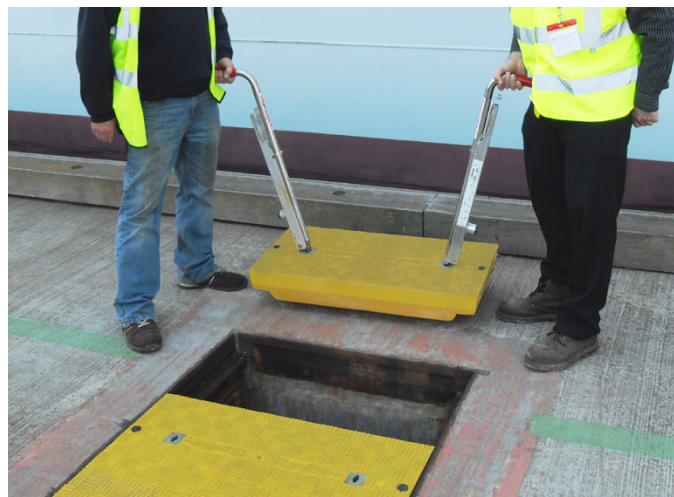
Enkel og sikker fjerning ved hjelp av Fibrelite-løftehåndtakene
