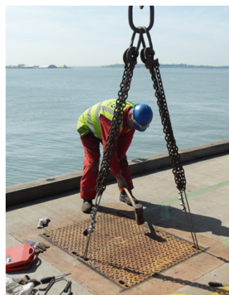
עלות גבוהה וזמן עבודה ארוך בעת הסרת המכסים שהיו מותקנים קודם
