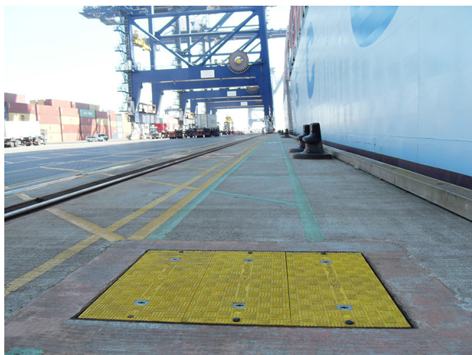
Il chiusino Fibrelite classe di carico 90 tonnellate installato nel molo
