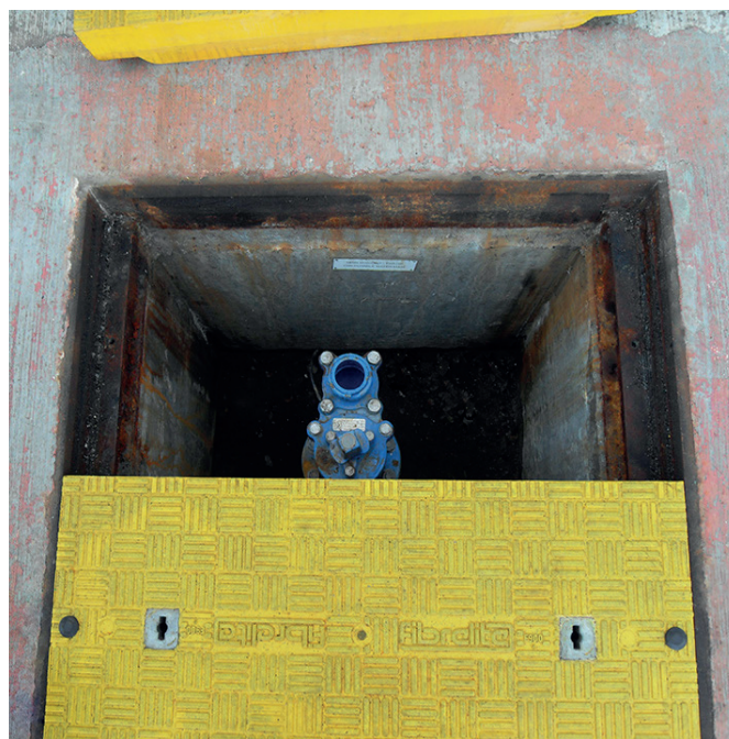
Poprzednio w celu zapewnienia dostępu do zaworu wody czystej konieczne było zdejmowanie ciężkich pokryw stalowych. Obecnie zdejmuje się tylko jedną, lekką pokrywę Fibrelite.
