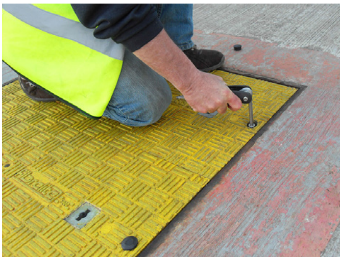
Obsługa zdejmuję śruby systemu zabezpieczającego Fibrelite
