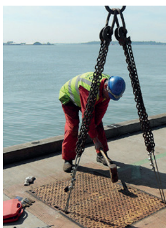
Drogie oraz czasochłonne zdejmowanie poprzednio zainstalowanych pokryw stalowych
