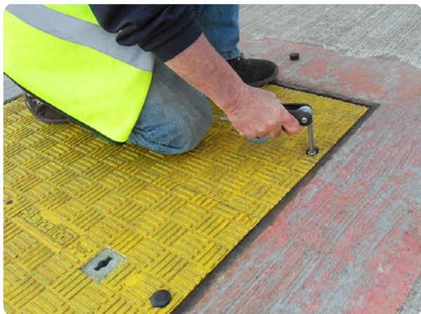
Obsługa zdejmuje śruby systemu zabezpieczającego Fibrelite
