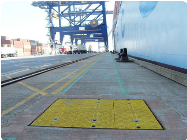
Lekkie pokrywy kanałowe w klasie obciążenia 90 ton w miejscu instalacji na nabrzeżu
