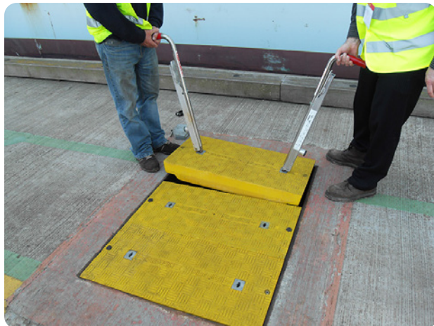
Proste i bezpiecznie otwarcie pokrywy za pomocą rączki Fibrelite
