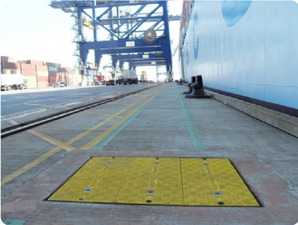
Paneles de peso liviano Fibrelite para carga de 90 toneladas instalados en el muelle
