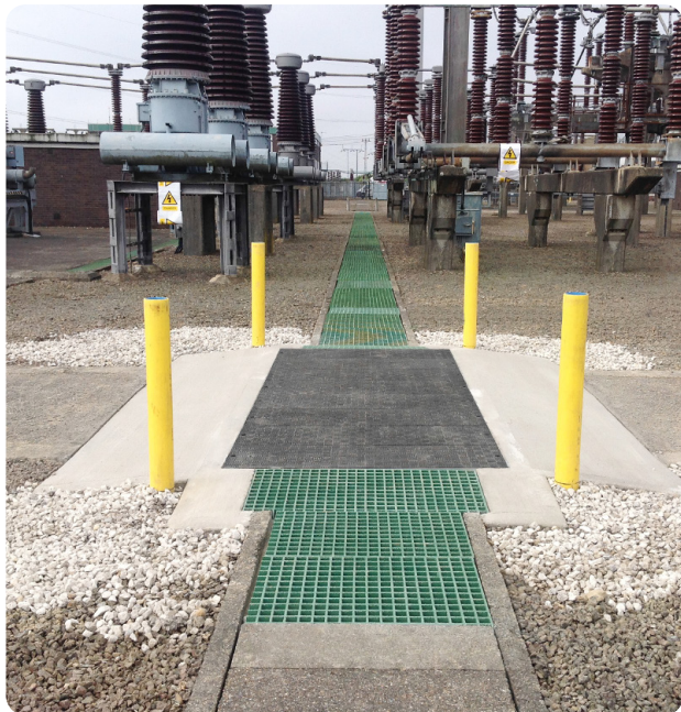
L'installation finale des tampons à grande capacité de charge Fibrelite
