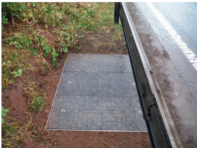
Lekkie pokrywy Fibrelite do kanałów w klasie obciążenia B125 (12,5 ton)
