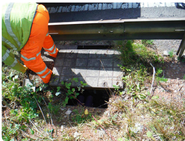
Uszkodzona pokrywa żeliwna i betonowa
