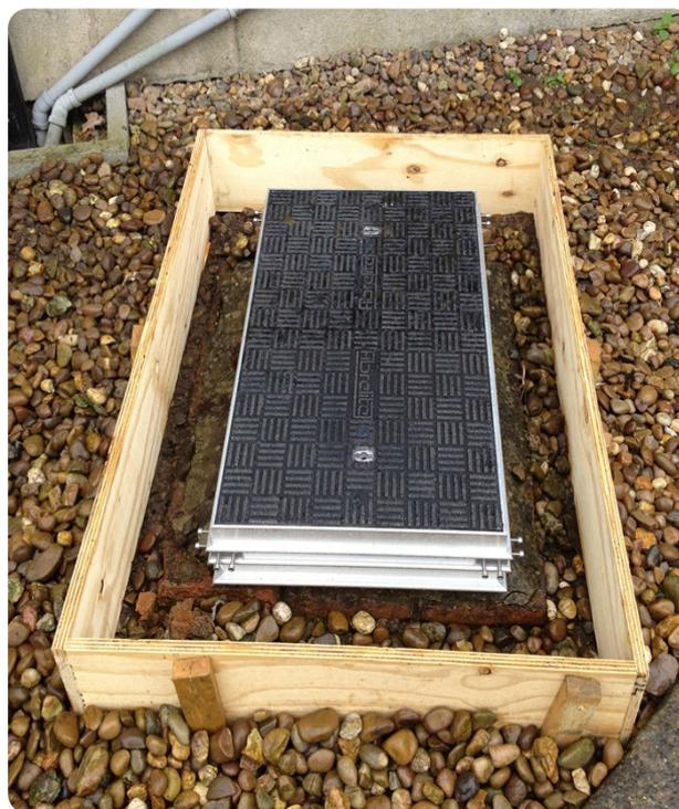
FM45 dans son coffrage prêt à être coulé dans du béton
