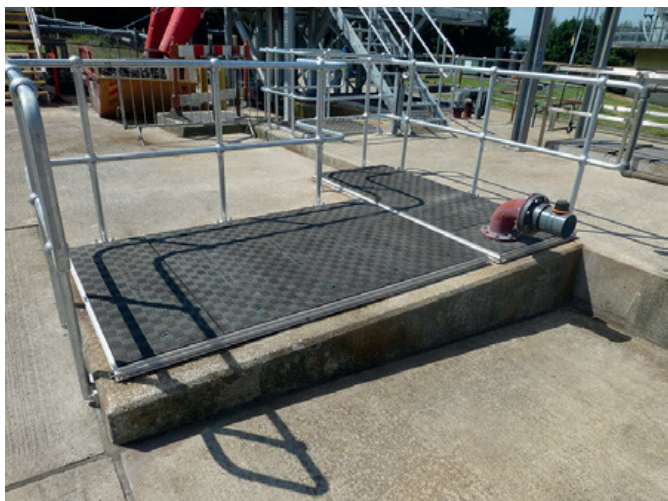
Specjalna rura odpowietrzająca może być wprowadzona w strukturę pokrywy
