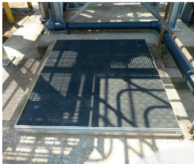
Super lekka pokrywa do kanałów Fibrelite w klasie obciążenia A15 (1,5 tony)
