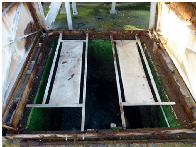
Stare i ciężkie mechaniczne stalowe pokrywy zostały wymienione na lekkie pokrywy Fibrelite
