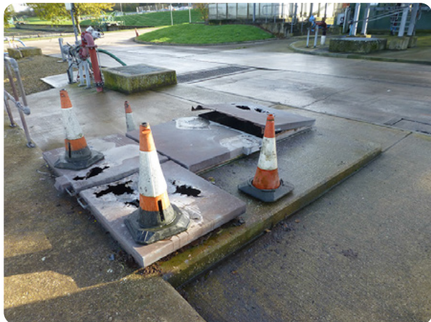
Poprzednio zainstalowane niebezpieczne i skorodowane pokrywy stalowe
