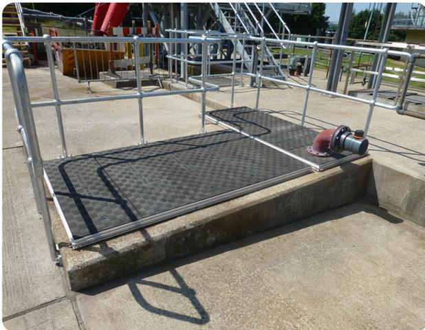
Tubería de ventilación incorporada a uno de los paneles Fibrelite
