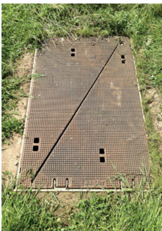
Zawodzące, ciężkie, metalowe pokrywy do podziemnych przewodów gazowych oraz mechaniczne podpory sprężynowe stanowią poważne ryzyko urazów przy pracy.
