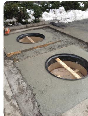
Les installations Fibrelite sont simples : une jupe en fibre de verre peut être utilisée afin de fixer le cadre à un niveau adéquat.
