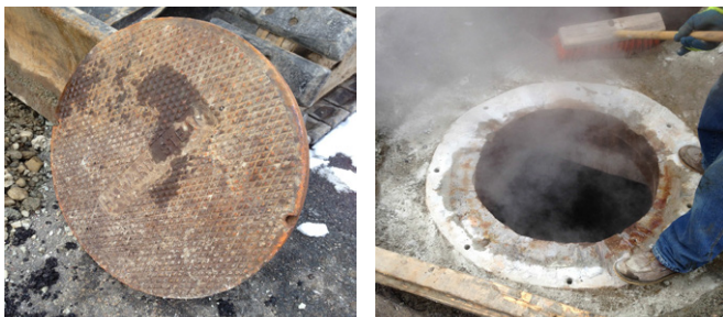
Große gusseiserne Abdeckungen sind sehr schwer und können sehr heiß werden wenn sie der Wärme im Schacht ausgesetzt sind.
