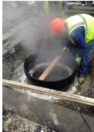
Ein Fiberglas Ring kann als Vorform benutzt werden um den Rahmen ebenerdig setzen zu können.
