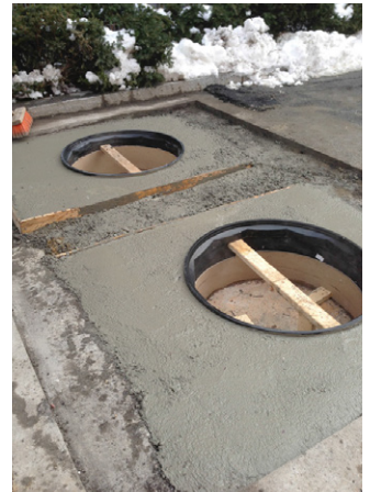
Ein Fiberglas Ring kann als Vorform benutzt werden um den Rahmen ebenerdig setzen zu können.
