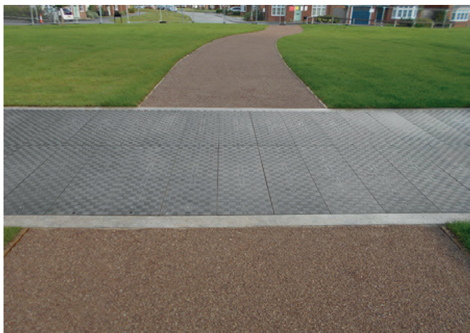
Specjalna struktura antypoślizgowa powierzchni pokryw Fibrelite
