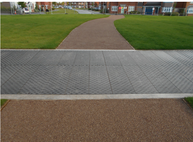
Padrão superficial das tampas Fibrelite incorpora um material especial antiderrapante para segurança adicional
