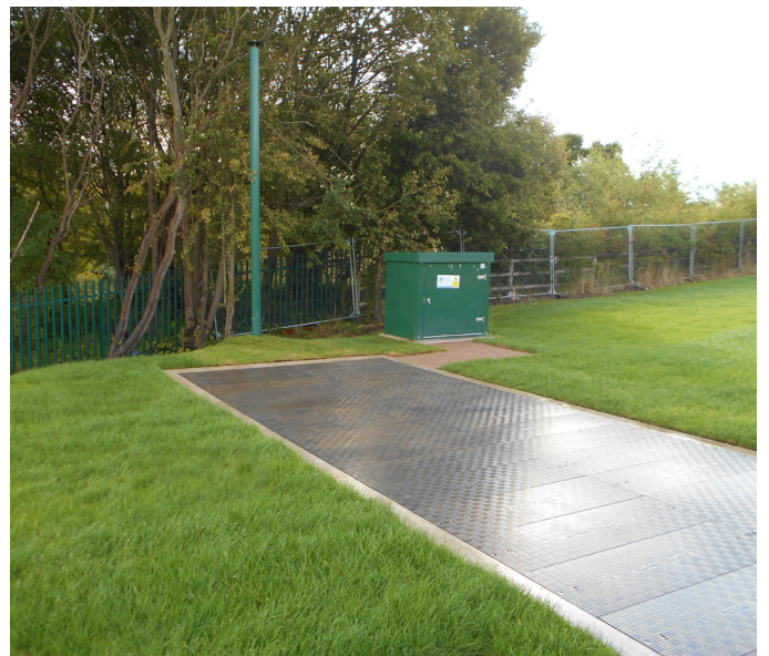
Cada tampa Fibrelite instalada neste projeto tem uma fechadura para segurança adicional
