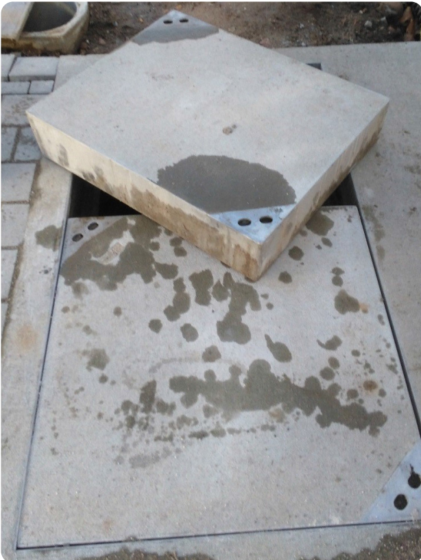
Die ursprünglich installierten, 17 cm starken Deckel aus Stahl mit Betonfüllung.
