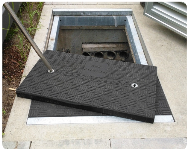
Unterkonstruktion mit Faserverbundabdeckungen vor der Trafostation.
