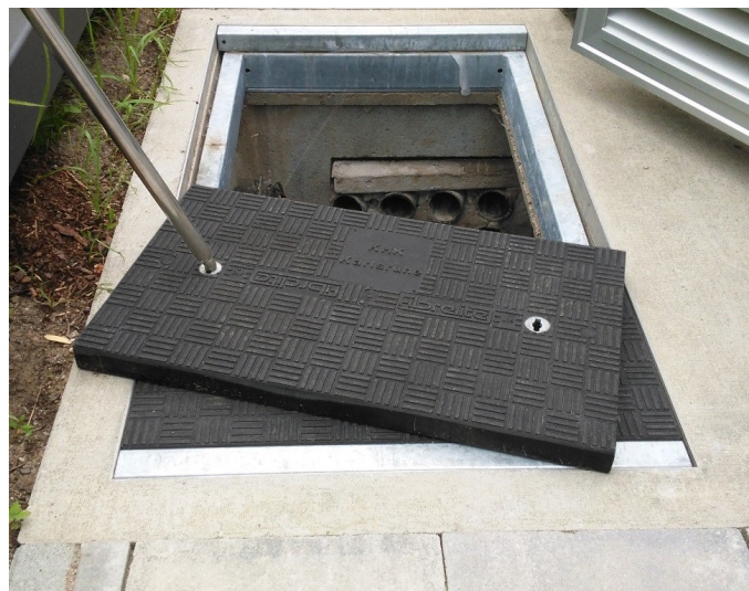
Pokrywy Fibrelite zainstalowane nad studnię kablową
