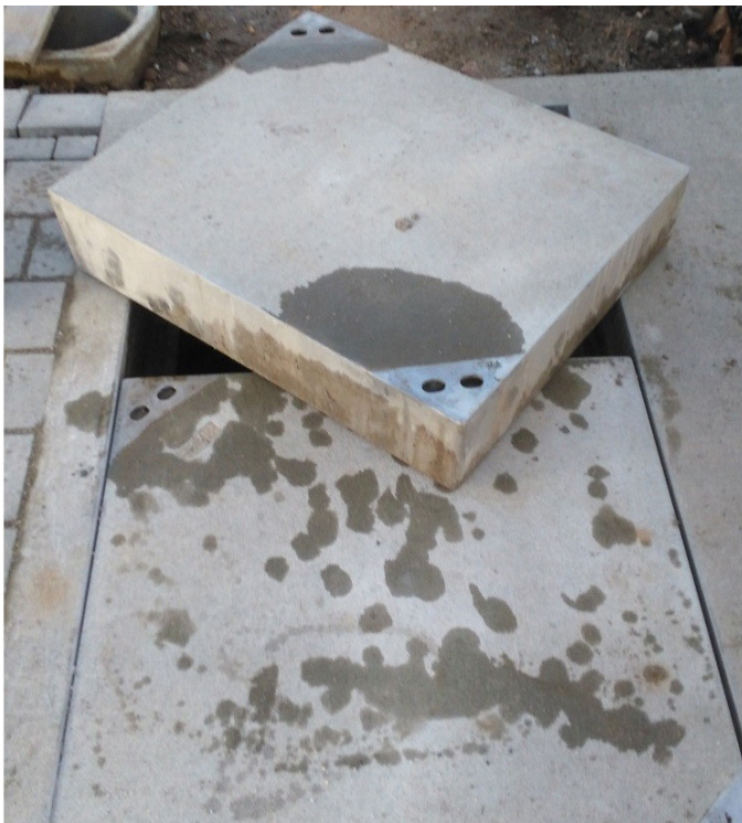
Oryginalne pokrywy stalowo-betonowe o głębokości 17cm
