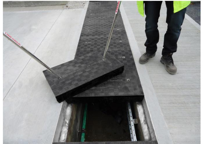
Las tapas Fibrelite se diseñan para aguantar cargas pesadas y condiciones meteorológicas severas durante muchos años (Imagen de una instalación similar usada como ilustración ya que el centro de datos real no se puede mostrar)
