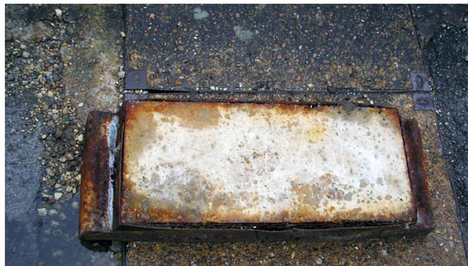
Разъеденный ранее установленный шарнир крышки
