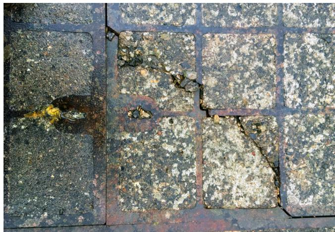
Глубокие трещины образовались в корродированных ранее установленных крышках
