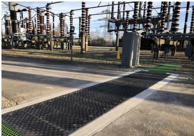
Fibrelite крышки и рамы были разработаны с учетом существующих отверстий
