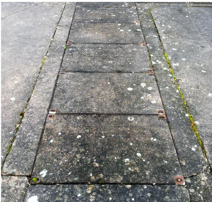
Из-за износа установленные ранее бетонные крышки представляют собой источник опасности даже для специалистов со специальным оборудованием
